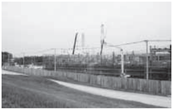
常総環境センター（手前は建設中の新型焼却炉）
