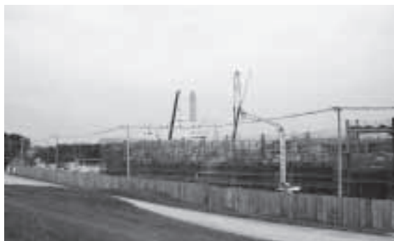
常総環境センター（手前は建設中の新型焼却炉）
