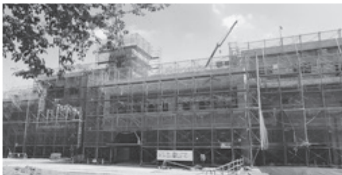
新校舎の建築が進む永山小学校
