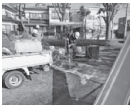
公園での除染作業
