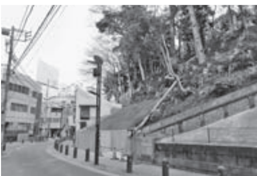
長禅寺下の急傾斜地
