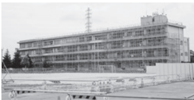
耐震化工事中の藤代小学校
