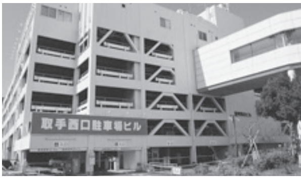
新町第8ビル駐車場
