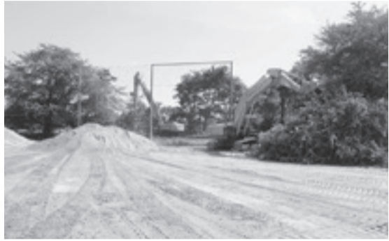
除染工事（中学校）
