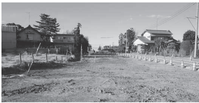
都市計画道路の工事状況（青柳）
