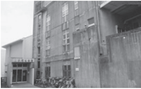
耐震改修工事が予定される福祉会館
