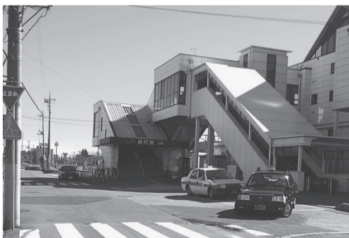
藤代駅北口(タクシー待機場)
