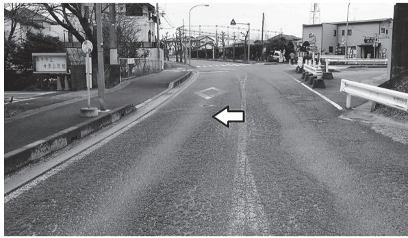
車道を写真左側にずらし右側の歩道を確保する(本郷)
