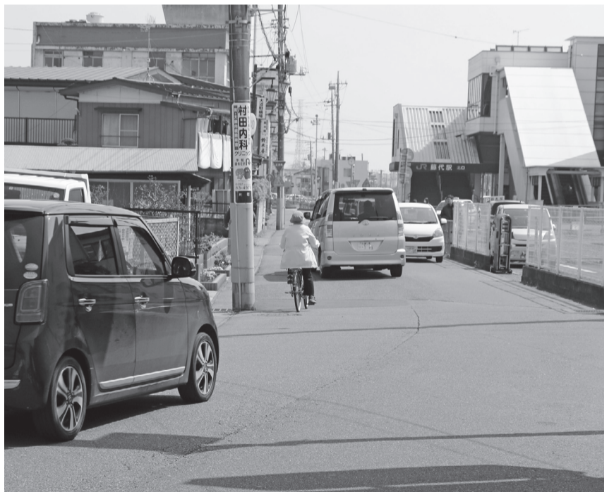
スムーズな相互通行が困難な藤代駅北口付近の道路
