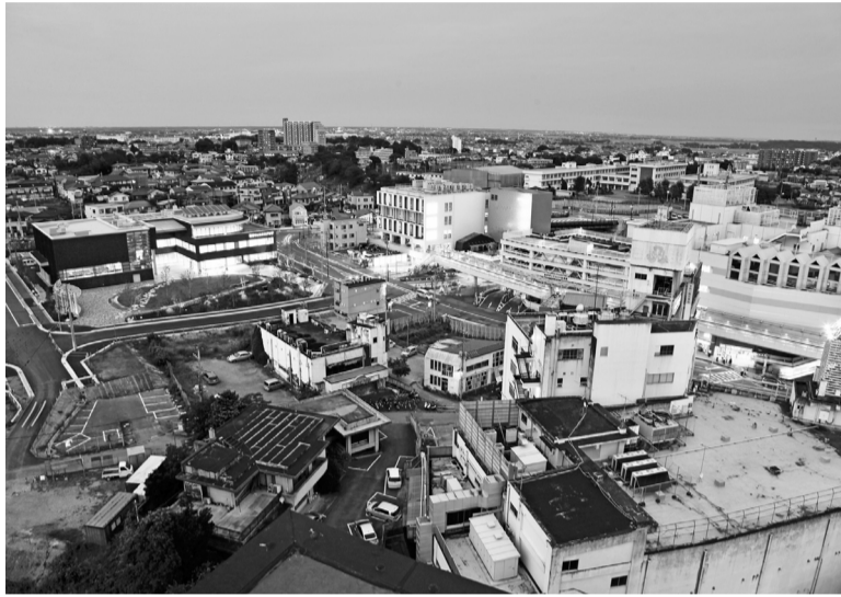
ウェルネスプラザなど取手駅西口地区
