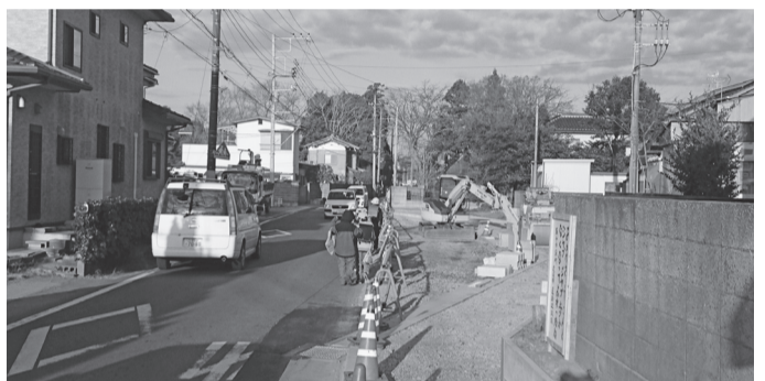
安全対策の工事が行われている通学路(下高井地内)
