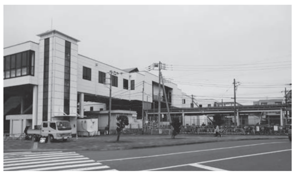
新しく防犯ステーションが設置される藤代駅南口
