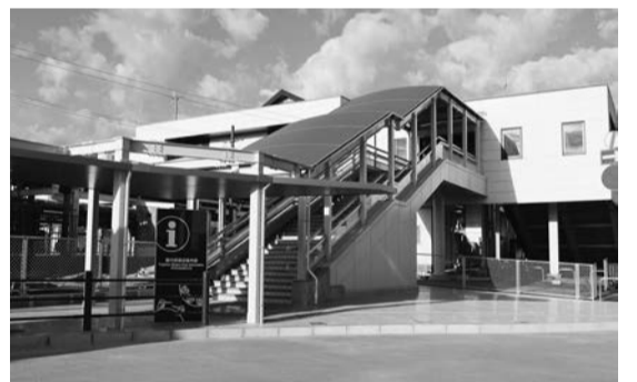
藤代駅北口が整備され、連絡階段等が新設
