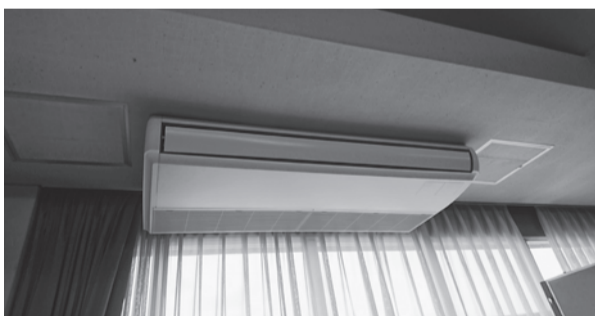
小中学校の普通教室にはエアコンが整備されているが、特別教室は一部を除いて未整備
