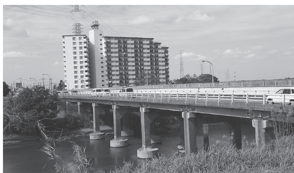
龍ヶ崎市側から見た小貝川に架かる文巻橋
