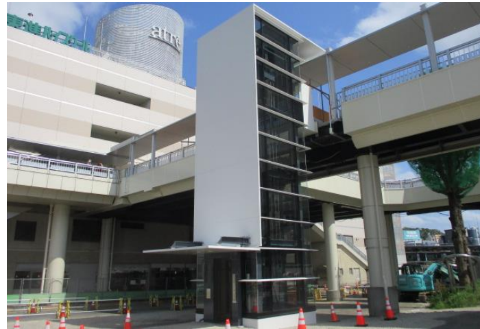
現在整備中の取手駅西口駅前に設置されたエレベーター
