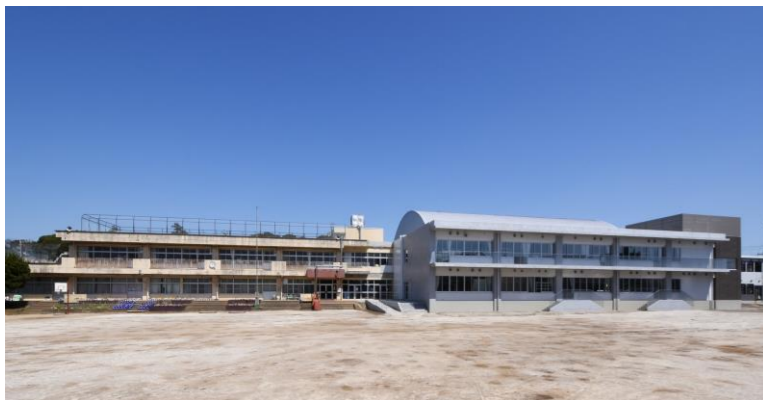
第2期工事により校舎が増築された白山小学校 (写真左側の校舎は第3期工事で改修予定)
