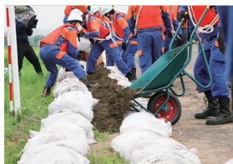
堤防の天端（上面）に土のうを積み越水を防止
