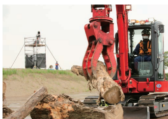
流入した障害物を重機で除去
