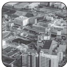
開発が進む取手駅の西口駅前地区
