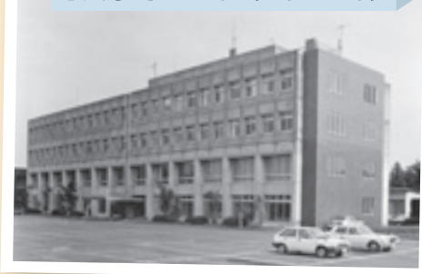
写真③ 庁舎増築（昭和49年）
