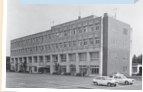
写真③ 庁舎増築（昭和49年）
