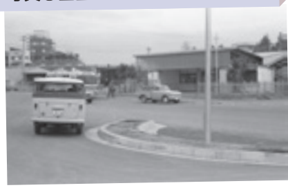
写真⑤西口木造駅舎(40年代前半)
