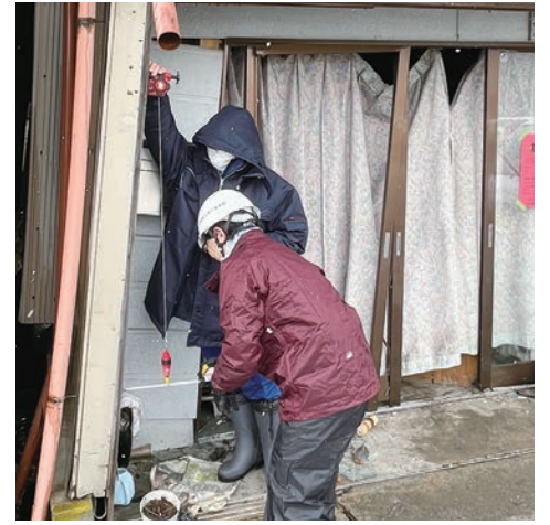
住家の被害認定調査のため傾きを測定
