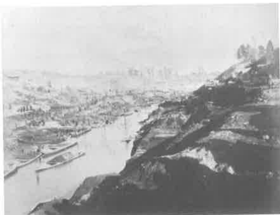
工事中の利根運河（所蔵 矢口浩氏、写真提供 流山市立博物館）
