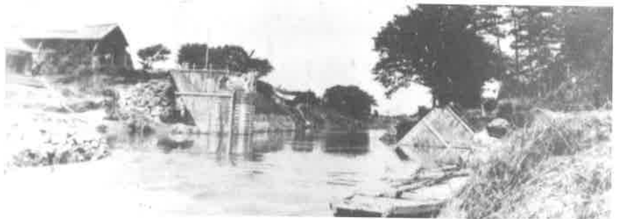
昭和16年7月の大洪水で破壊された水堰橋 （所蔵 山中金三氏、提供 流山市立博物館）
