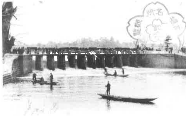
煉瓦塙の岡堰(利根町立歴史民俗資料館寄託文書赤松宗旦家伝資料) 北相馬郡長となった広瀬は、煉瓦による岡堰の改修を計画します。この煉瓦塙は明治20年に竣工しましたが、同31年の洪水で大破してしまいました。この写真は、翌32年に修築された12連の煉瓦造可動堰です。
