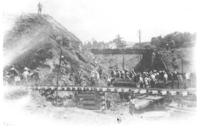
鉄道連隊の作業光景①(佐藤宗一氏所蔵) 取手駅の北側の台地を削った土をトロッコに積み、さらに貨車に積み替えています。軍人のほかに勤労奉仕隊の人も働いています。女性の姿もかなり見られます。
