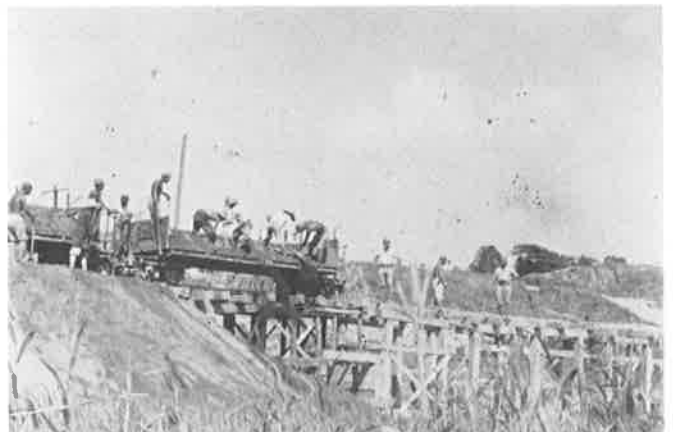
鉄道連隊の作業光景③(佐藤宗一氏所蔵) 架設の木橋を延ばしながら、堤防に沿って土を積み上げていくようすがわかります。
