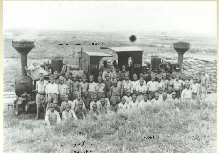
津田沼鉄道連隊の利根川木橋架設作戦(佐藤宗一氏所蔵)
