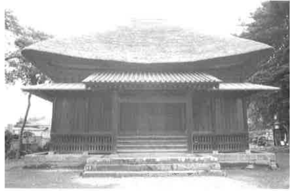
昭和60年からの解体修理前の三仏堂
