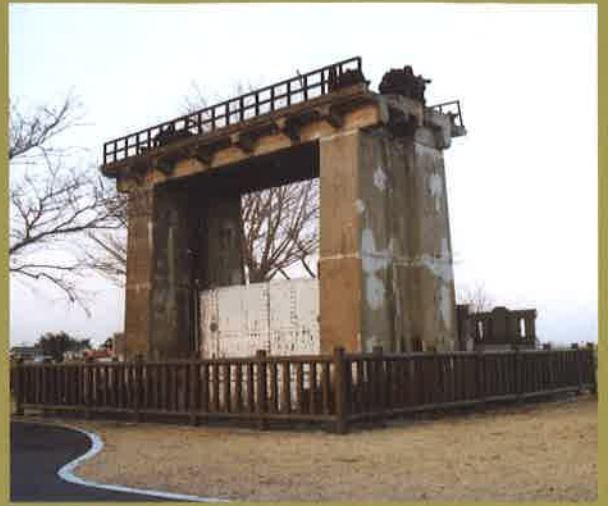
岡堰中の島に保存されているコンクリート堰(可動堰)
