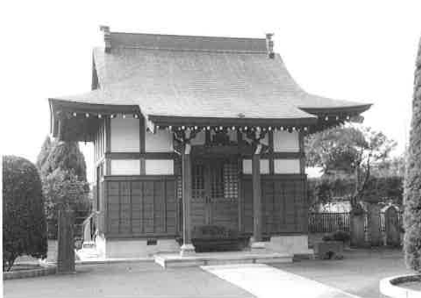
浄円寺境内の伊奈観音堂
