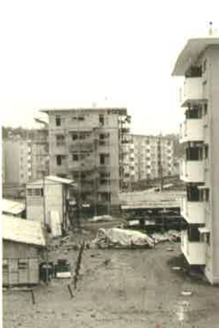
建設中の井野団地 (取手市教育委員会所蔵)
