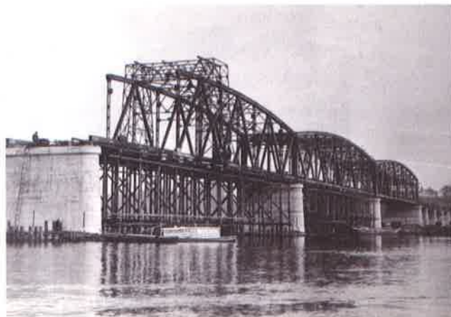
工事中の大利根橋(個人蔵)
