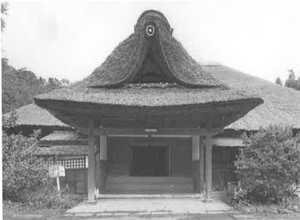
修理前の取手宿本陣主屋
