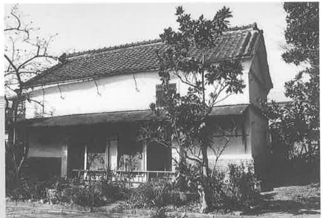
修理前の取手宿本陣土蔵
