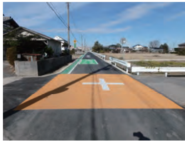
整備後の六郷地区（事例③）
