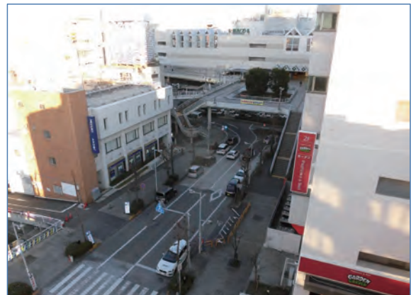
工事前、はなのき通り側から西口交通広場方向を望む
