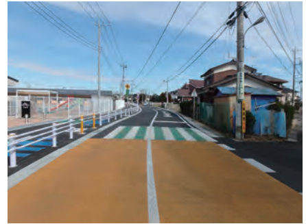
整備後の井野地区（事例①）
