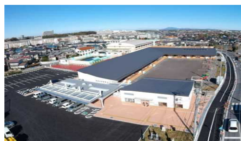
令和2年1月よりICT化を進める井野なないろ保育所・地域子育て支援センター
