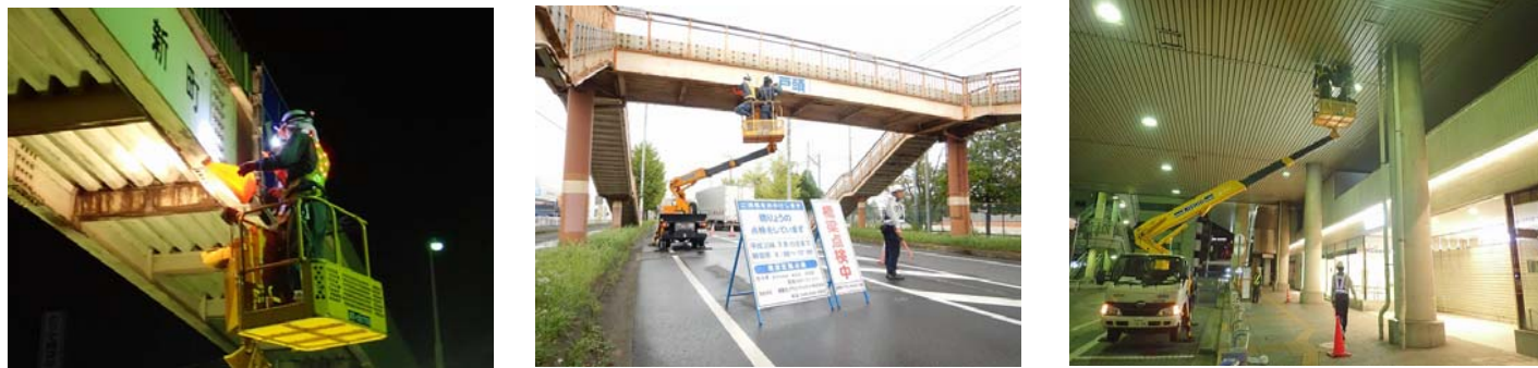
写真3-1. 横断歩道橋点検状況
