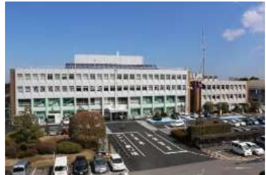
市本庁舎等に太陽光発電を設置
