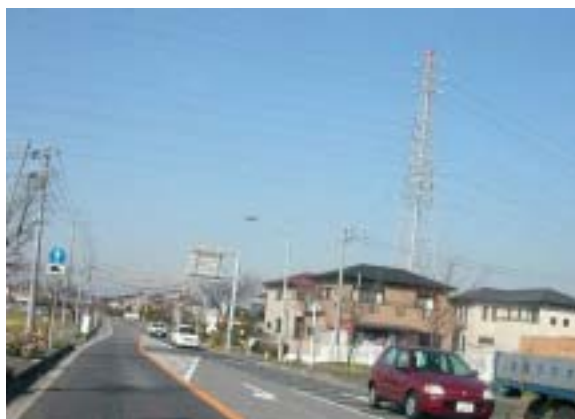
写真1 藤代町柵木付近
