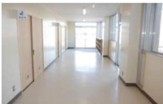
玄関・ホール
