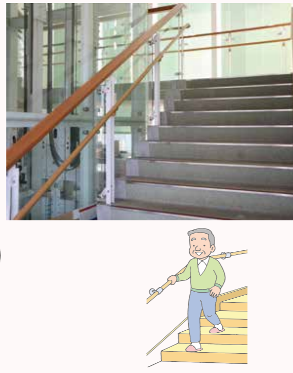
● 手すりの設置 (例)
